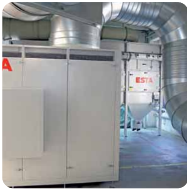
Absaugsystem in separatem Raum
